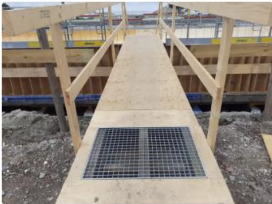
Toegangsbrug met schoonlooprooster
